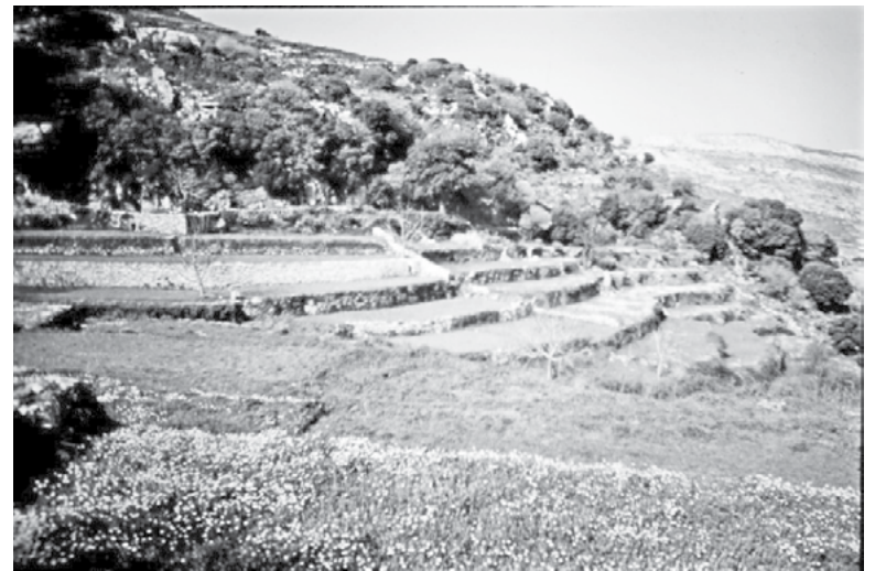
Παλιές πεζούλες στη Νάξο που ανακατασκευάζονται και συντηρούνται συνεχώς.
